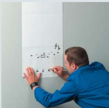
1. Используйте специальный шаблон для монтажа
