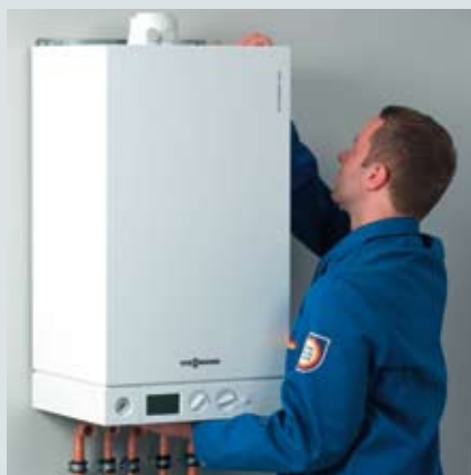
2. Закрепите котел на стене
